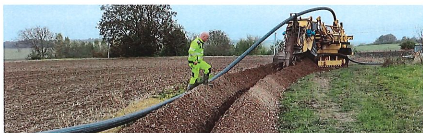
Un siècle plus tard, les machines ont remplacé la pelle et la pioche.
